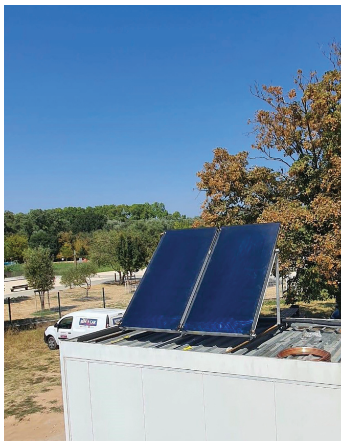
• Figure 3 Panneaux solaires thermiques (ci-dessus) reliés à la cuverie thermorégulée.
